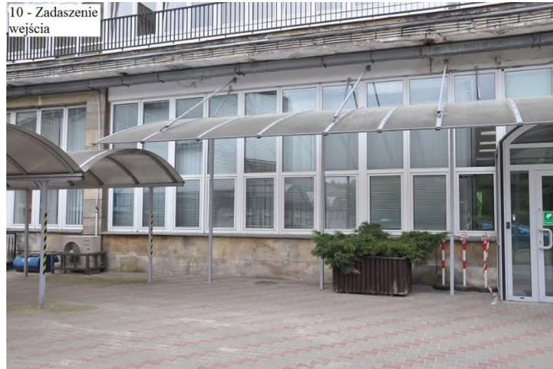
Zdjęcie nr 10 - Zadaszenie wejścia
