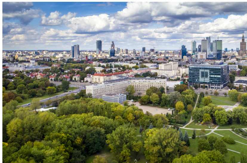
Gmach budynku GUS przy Al. Niepodległości 208 w Warszawie
