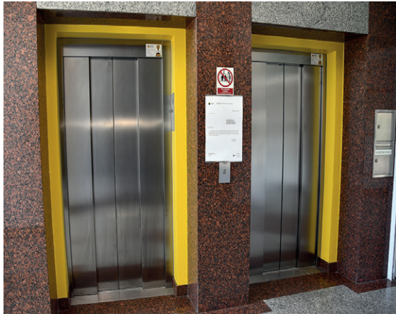
Dostępność architektoniczna w budynku GUS. Oznakowana winda
