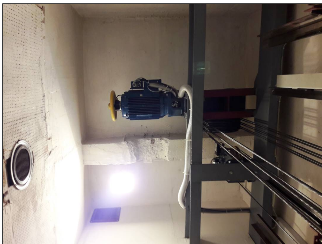
Nadszybie z zespołem napędowym dźwigu [6]
