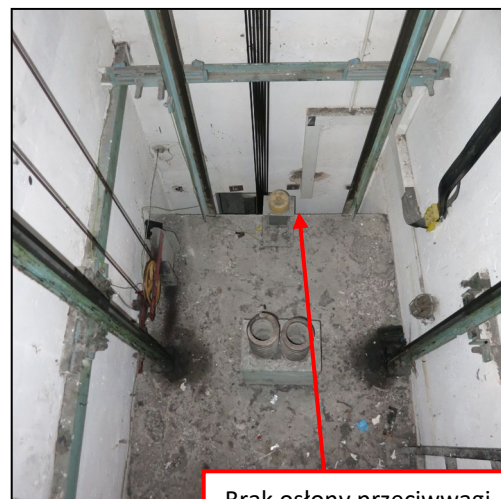
Brak osłony przeciwwagi
