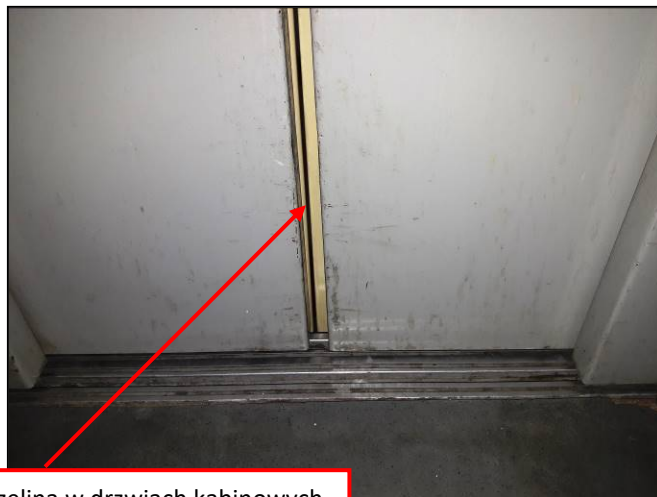
Szczelina w drzwiach kabinowych
