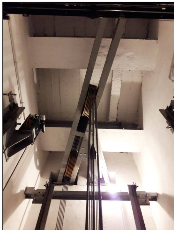
Nadszybie dźwigu prawego [8]
