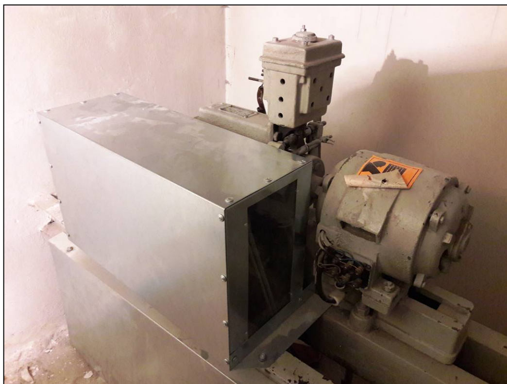
Wciągarka dźwigu [11]
