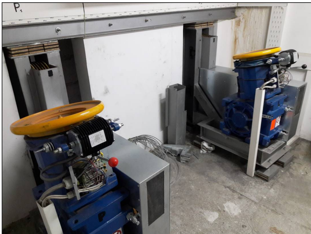
Wciągarki dźwigów lewego i prawego [7, 8]
