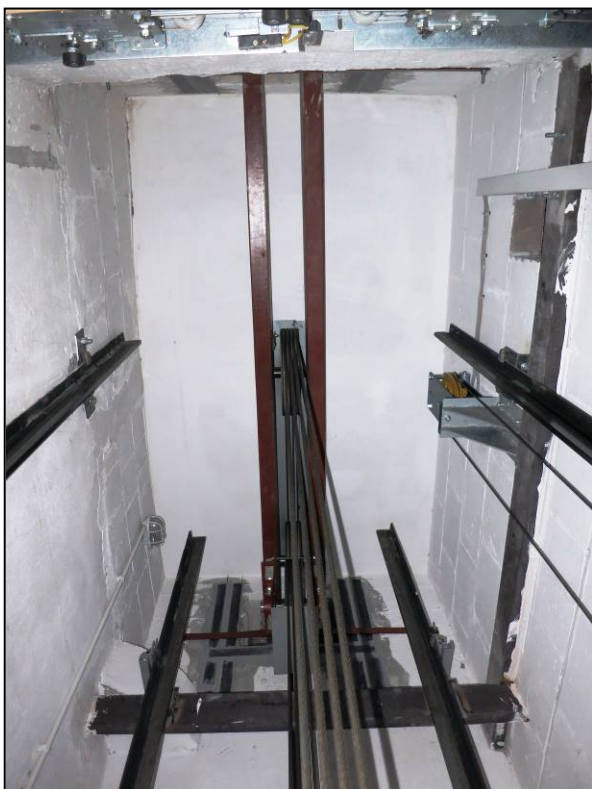
Nadszybie dźwigu lewego [1]
