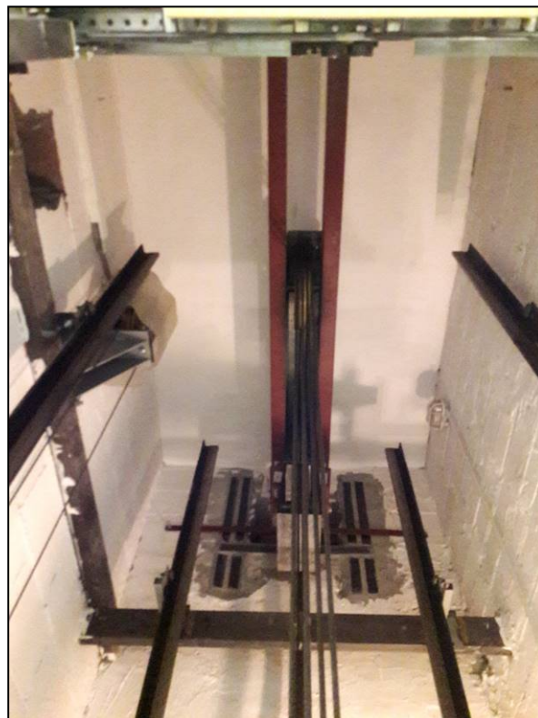
Nadszybie dźwigu prawego [2]
