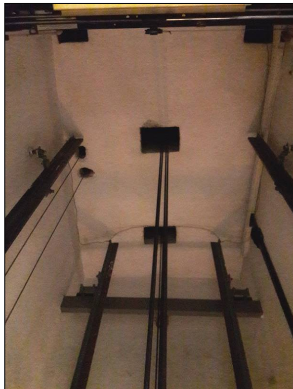
Nadszybie dźwigu prawego [5]
