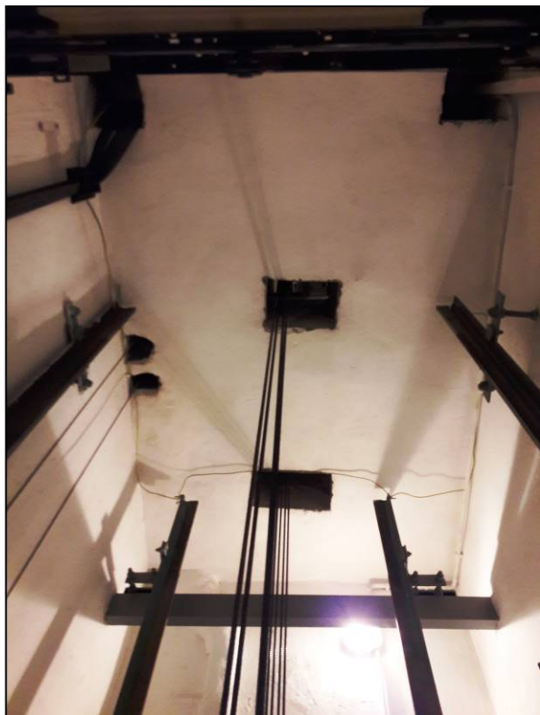
Nadszybie dźwigu lewego [4]
