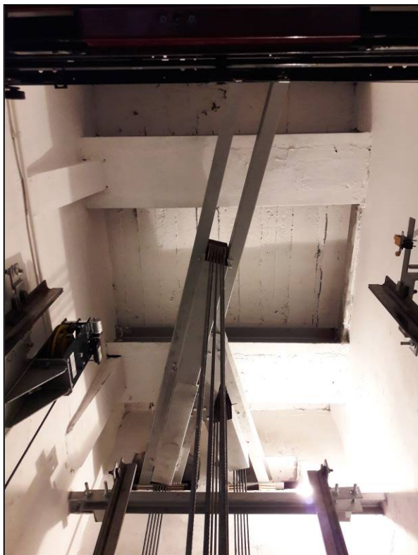
Nadszybie dźwigu lewego [7]
