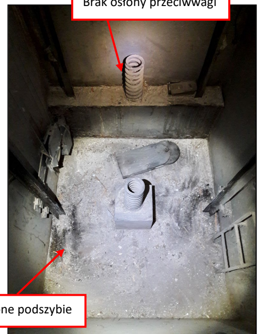
Brak osłony przeciwwagi
