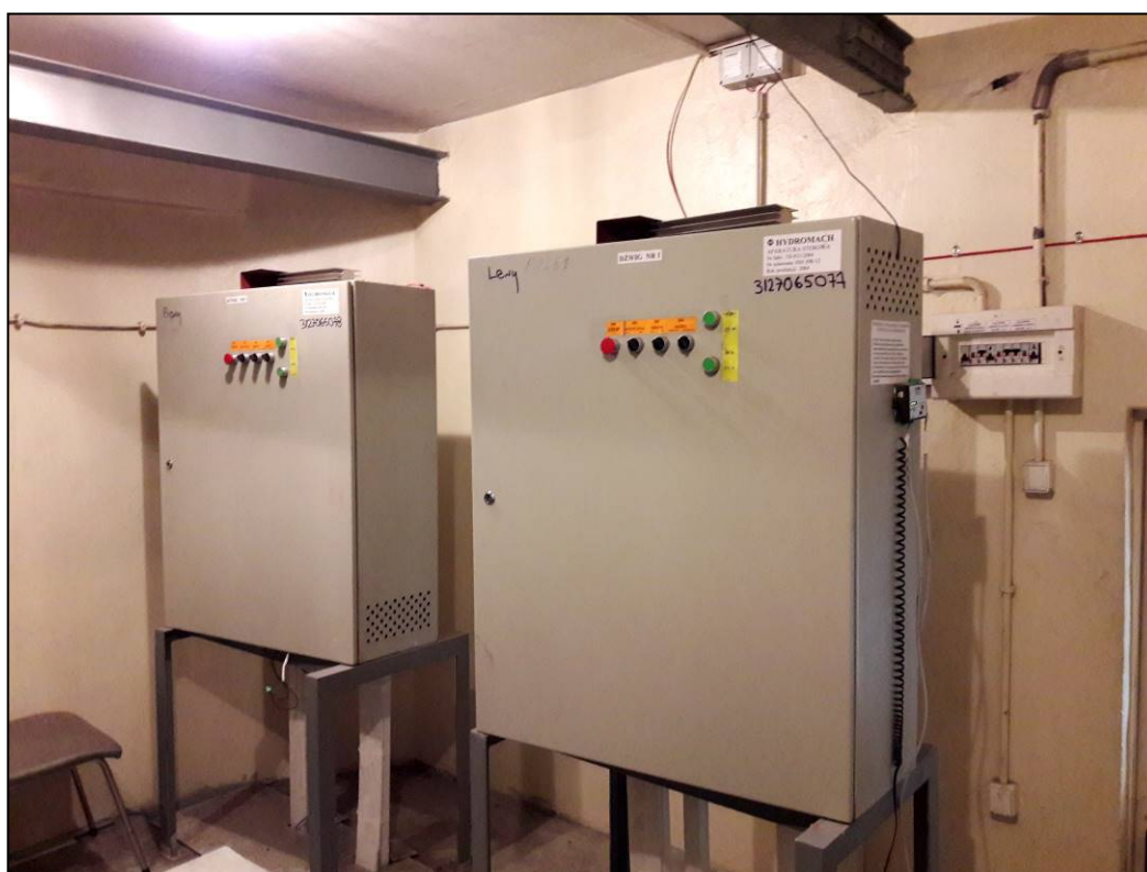
Tablice sterowe dźwigów lewego i prawego [4, 5]
