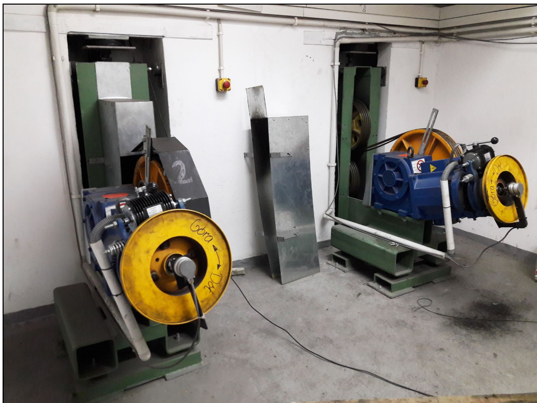
Wciągarki dźwigów lewego i prawego [1, 2]
