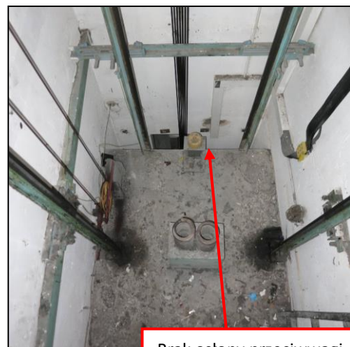
Brak osłony przeciwwagi
