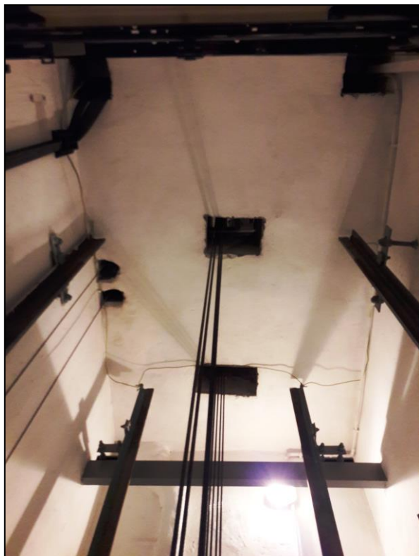
Nadszybie dźwigu lewego [4]
