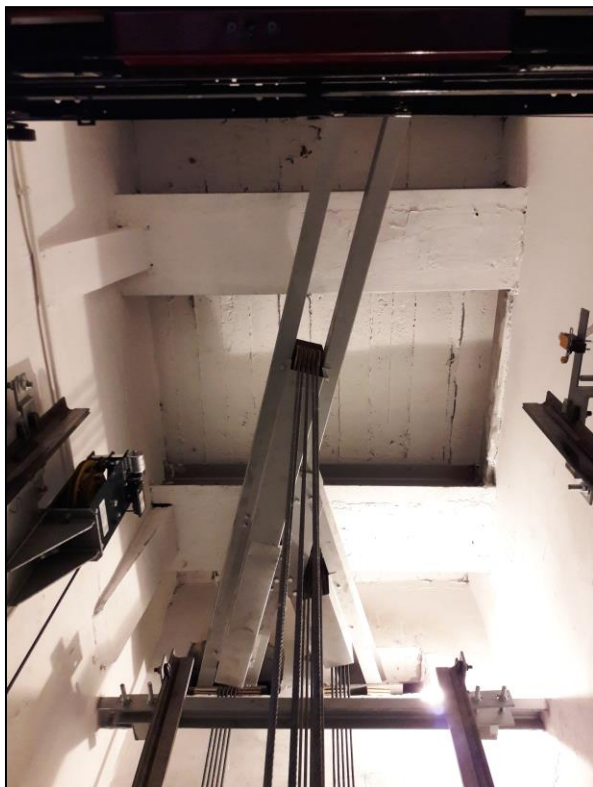
Nadszybie dźwigu lewego [7]
