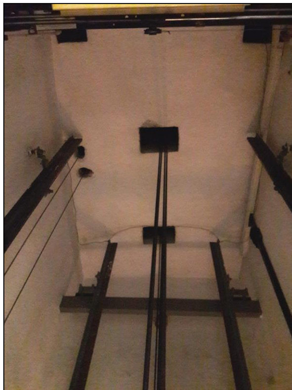
Nadszybie dźwigu prawego [5]
