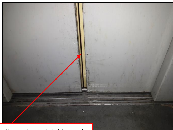
Szczelina w drzwiach kabinowych
