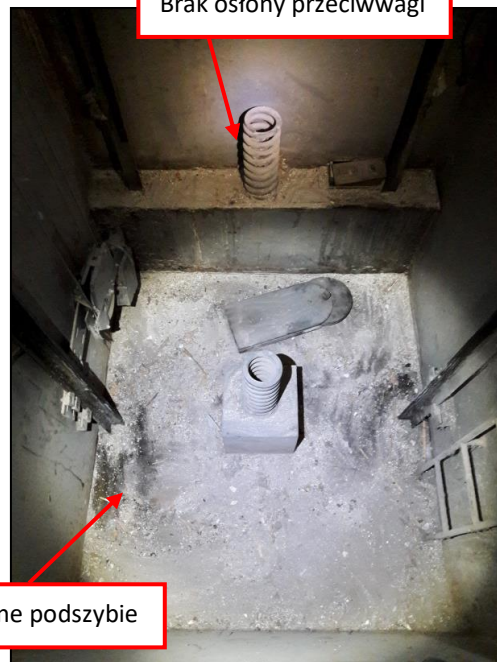
Brak osłony przeciwwagi
