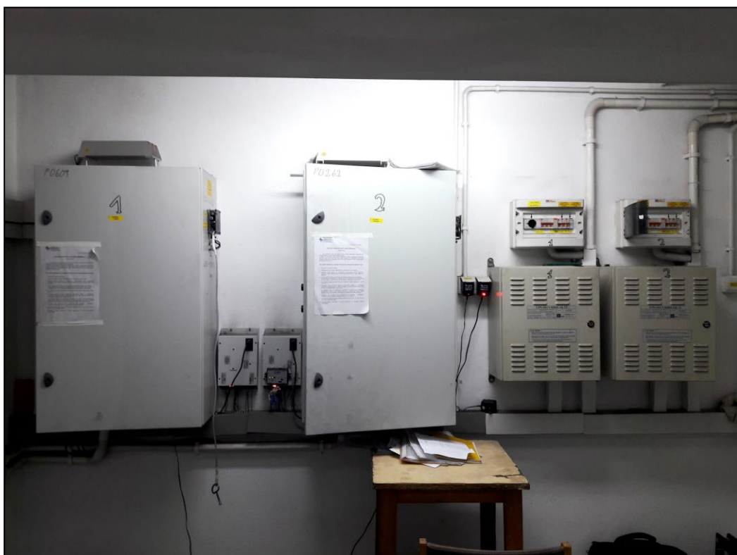
Tablice sterowe, tablice wstępne i zasilacze UPS dźwigów lewego i prawego [1, 2]
