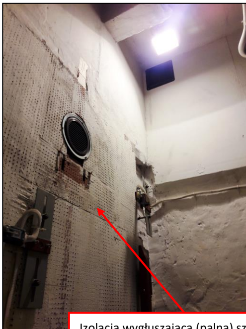
Izolacja wygłuszająca (palna) szybu
