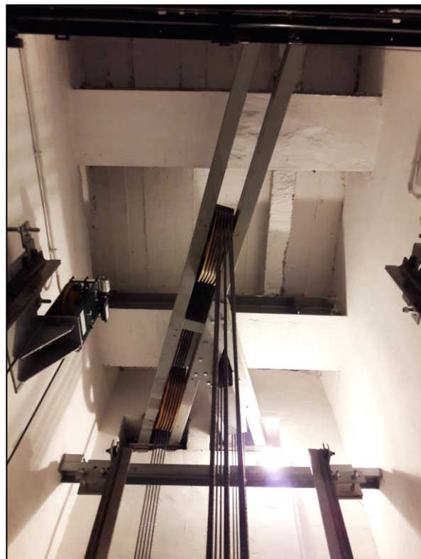
Nadszybie dźwigu prawego [8]
