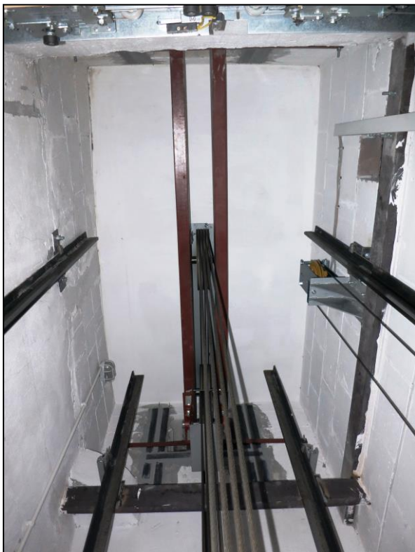
Nadszybie dźwigu lewego [1]
