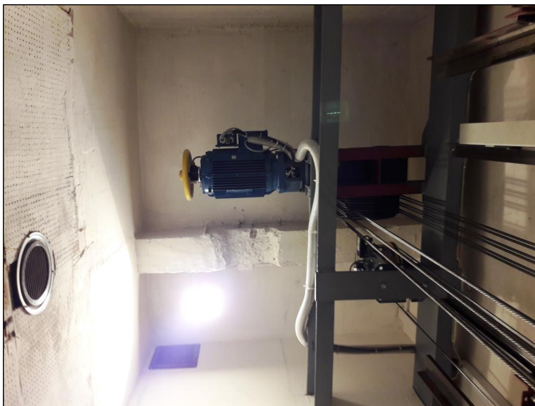
Nadszybie z zespołem napędowym dźwigu [6]
