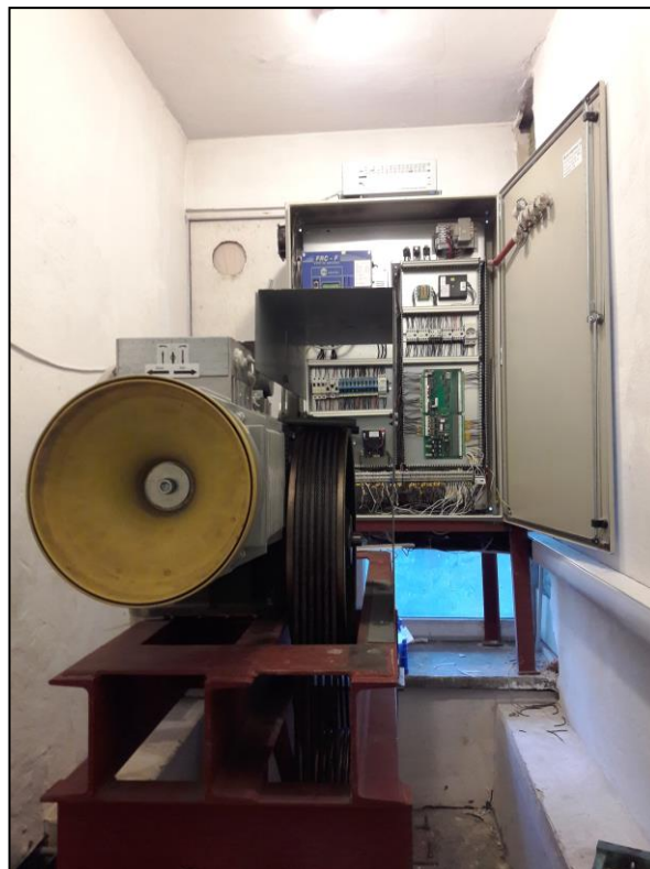
Maszynownia dźwigu [3]
