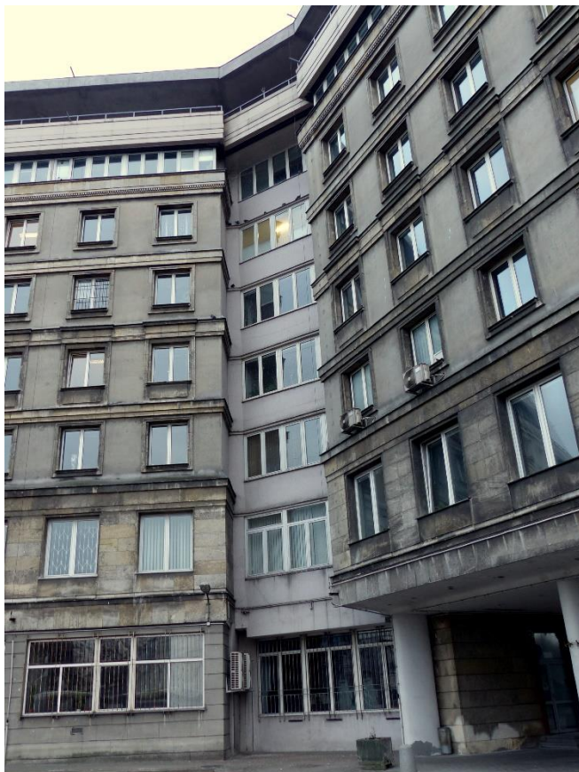
6. Widok na wąską elewację północną łącznika trzech skrzydeł budynku, z fragmentami elewacji skrzydeł „A” i „B”.
