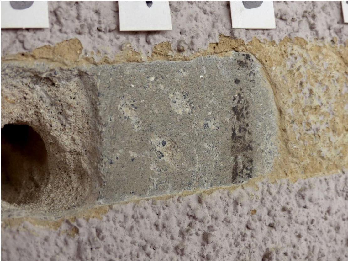
26. Fragment odkrywki nr 2 z sondą do cegły i odsłoniętymi nawarstwieniami technologicznymi. Na oryginalnej powierzchni tynku widoczny ślad brązowej farby.
