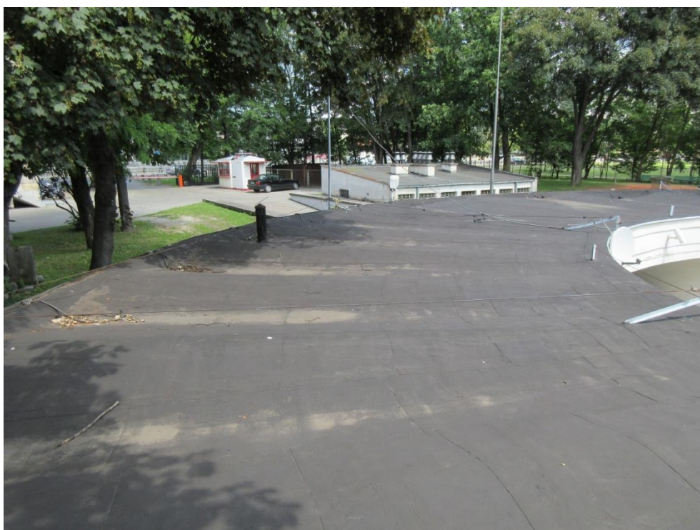
Fot. 18. Dach garaży, w tle budynek techniczny.
