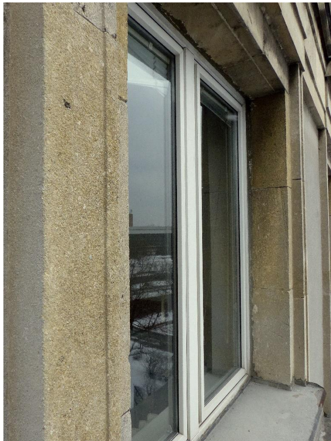
37. Opaska kamienna piętego okna trzeciego piętra, od strony południowej elewacji zachodniej skrzydła „C”.
