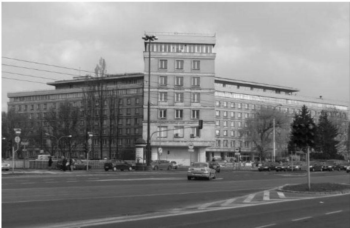
45. Widok na elewację budynku GUS-u w kierunku południowo-wschodnim z Alei Niepodległości nad Trasą Łazienkowską. Fotografia wykonana prawdopodobnie w latach 90-tych.
