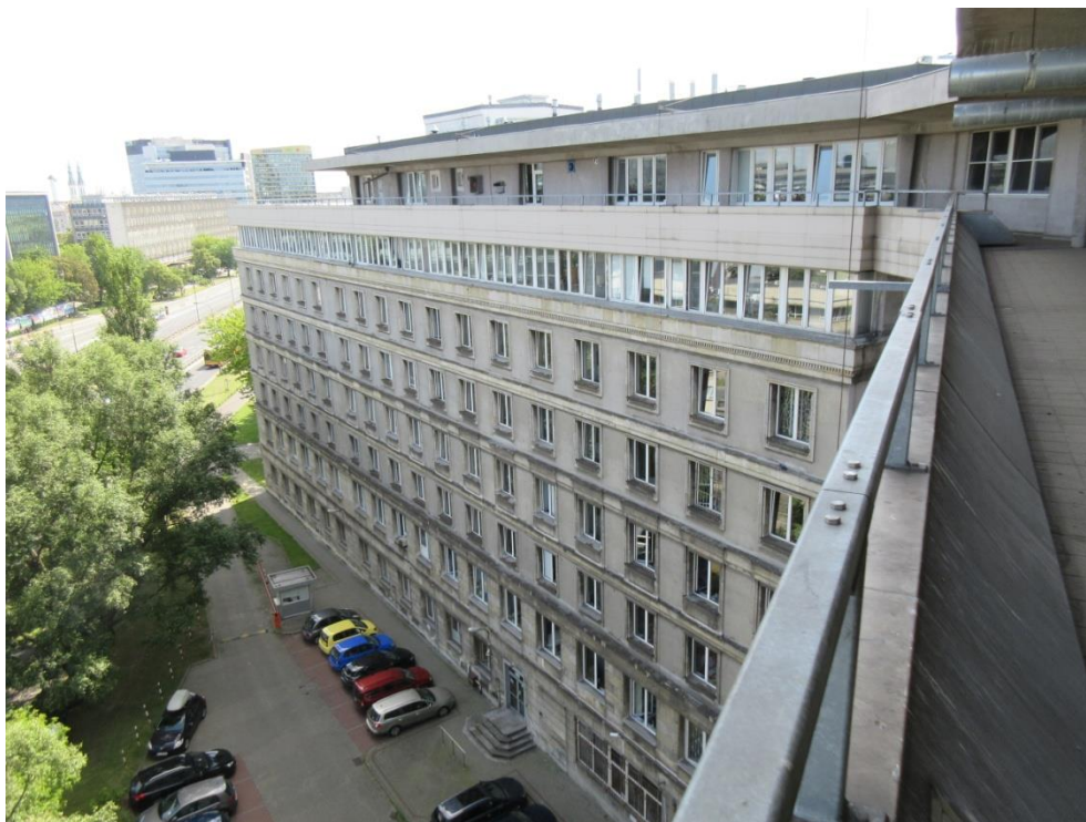
Fot. 5. Elewacja północna od al. Armii Ludowej.
