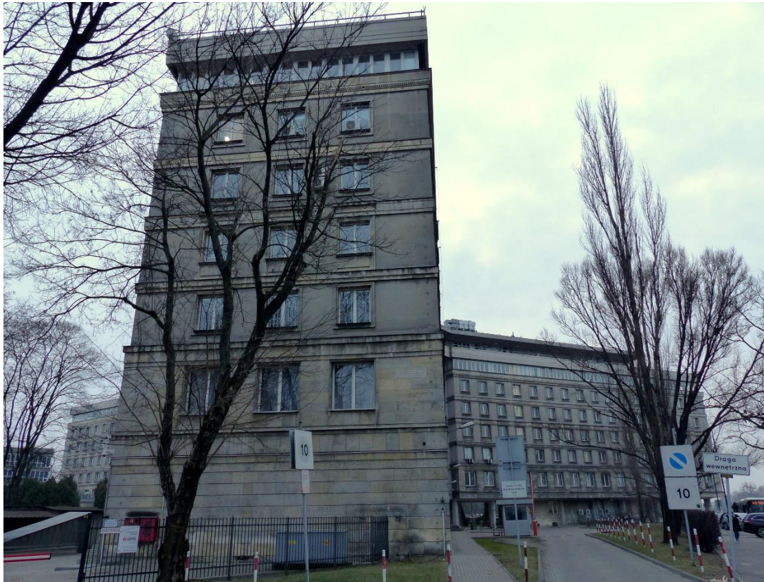
8. Widok na elewację szczytową, północno-wschodnią skrzydła „B” . W głębi po prawej stronie widać skrzydło „A”, a po lewej fragment skrzydła „C” budynku.
