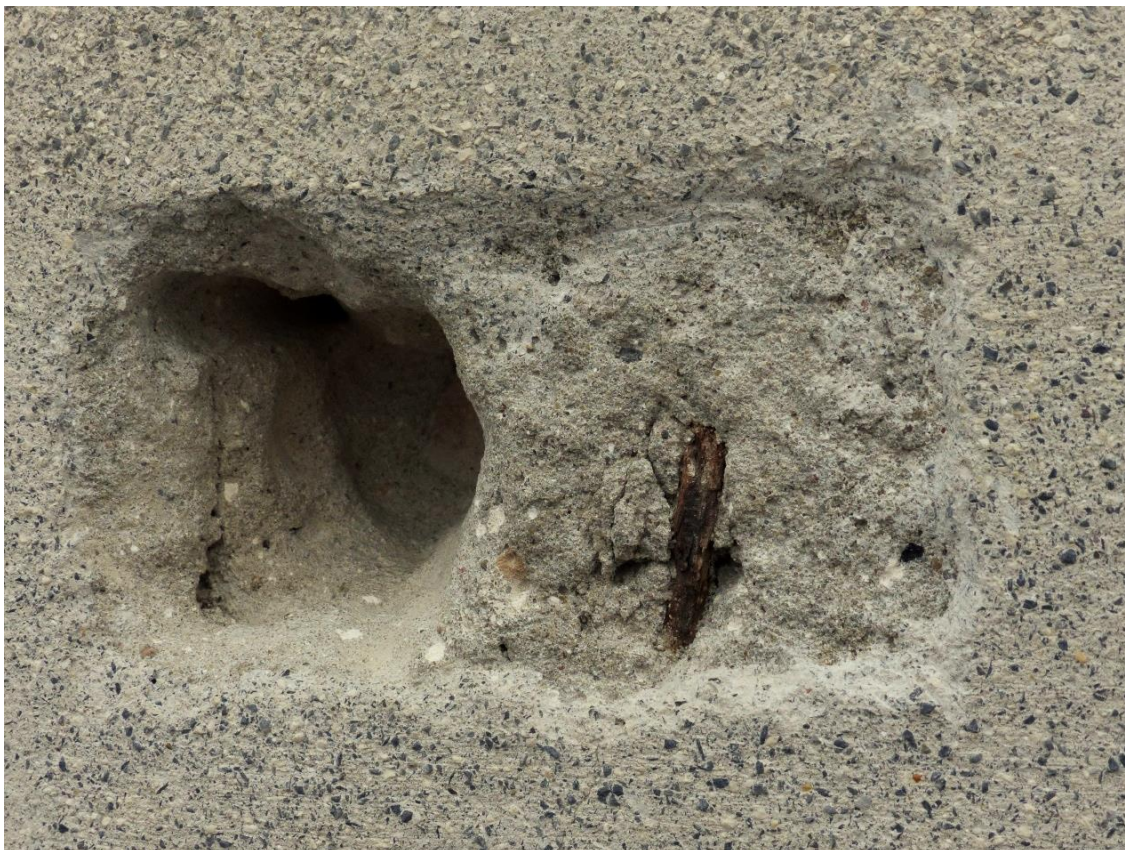
19. Sonda do cegły w odkrywce nr 1.
