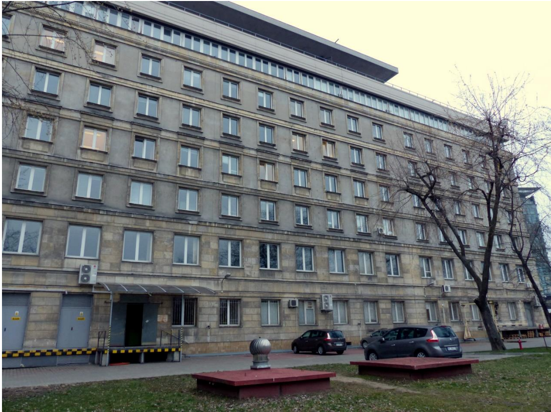
9. Widok w kierunku północno-wschodnim na elewację południowo-wschodnią skrzydła „B” gmachu.
