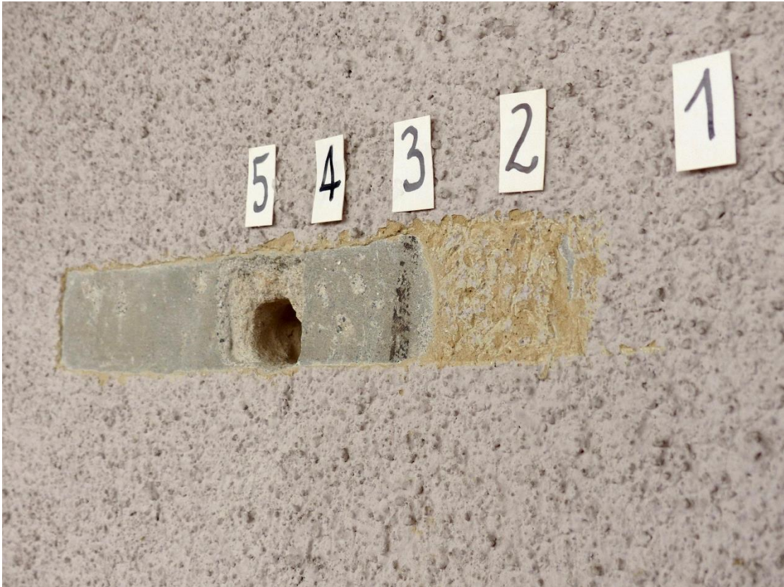
24. Odkrywka nr 2, widok z prawej strony.
