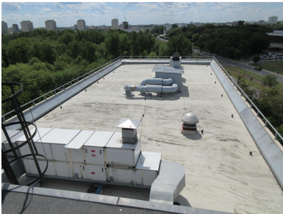
Fot. 17. Dach nad skrzydłem południowym.
