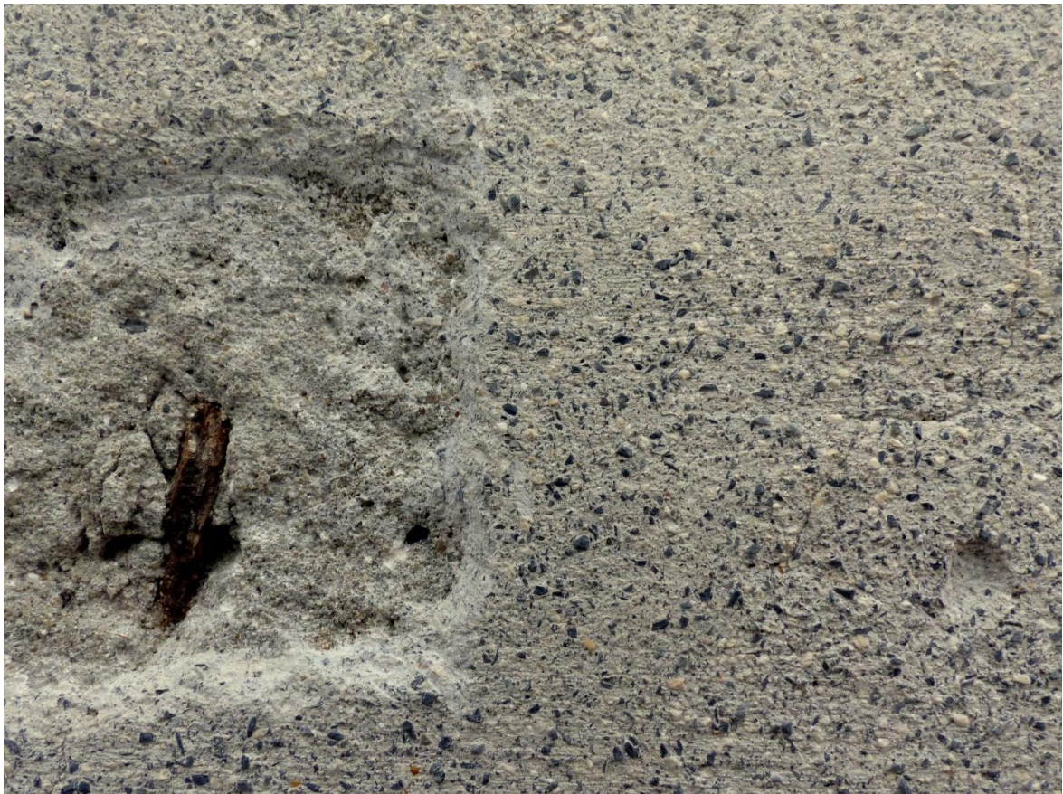
18. Fragment odkrywki nr 1, z widoczną strukturą tynku szlachetnego wierzchniego i spodniego tynku wyprawy.
