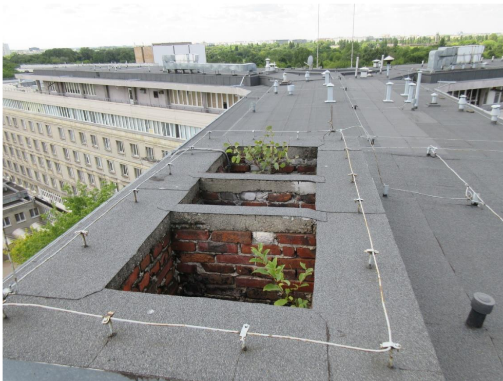
Fot. 11. Ulokowanie szybów wentylacyjnych (Fot.8-10).
