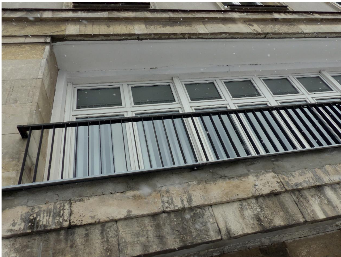
36. Fragment elewacji zachodniej skrzydła „C” na I piętrze, obłożonej płycinami wapienia.
