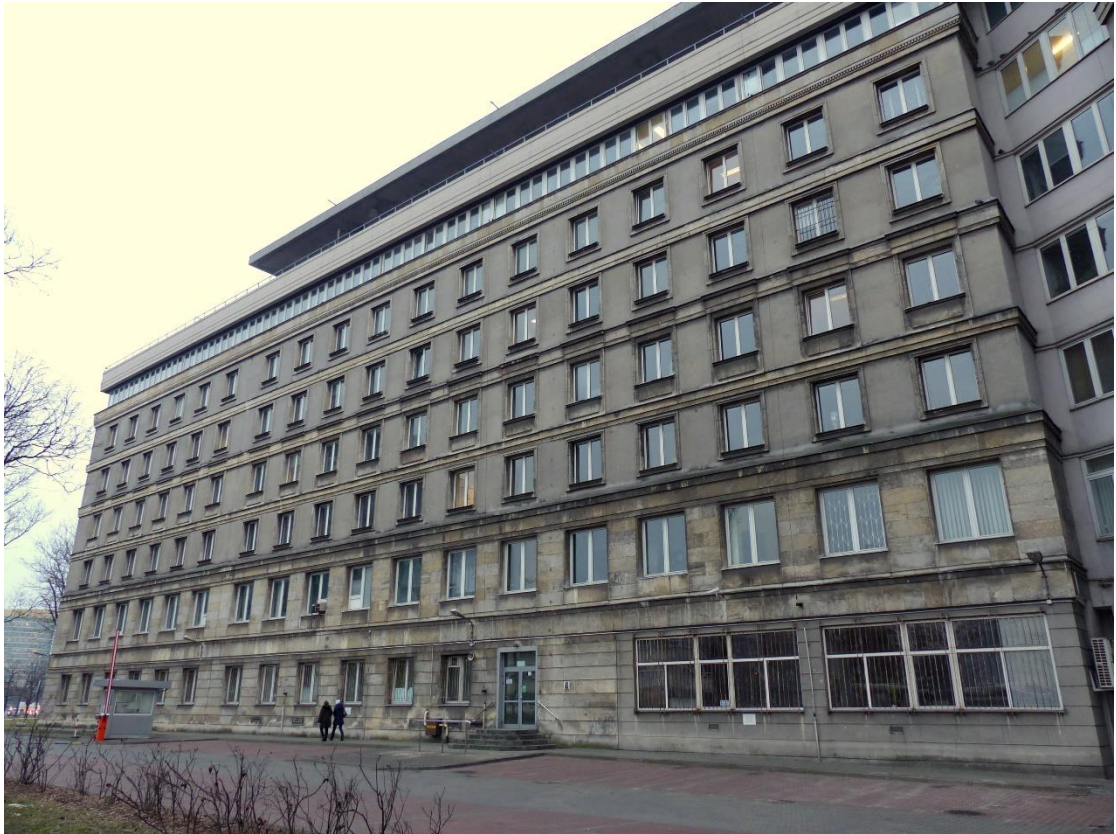
7. Widok w kierunku południowo-wschodnim na elewację północno-wschodnią skrzydła „B” gmachu.
