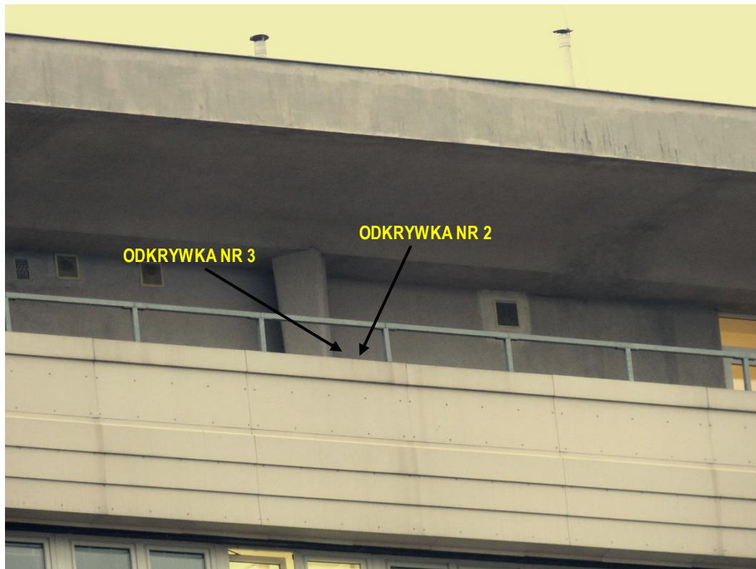
20. Fragment elewacji wschodniej skrzydła „C” gmachu, z oznaczeniem lokalizacji odkrywek nr 2 i nr 3.
