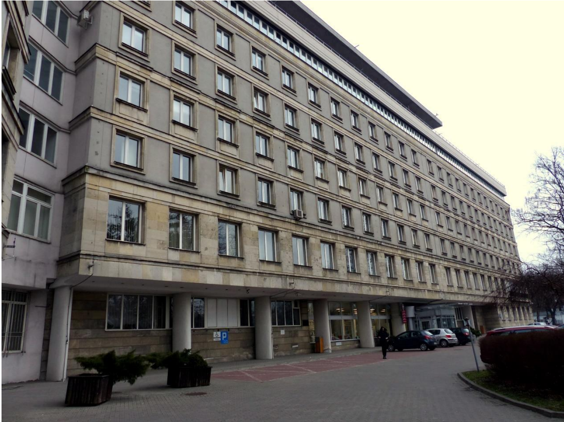
3. Widok w kierunku południowo-wschodnim na elewację zachodnią skrzydła „C”.
