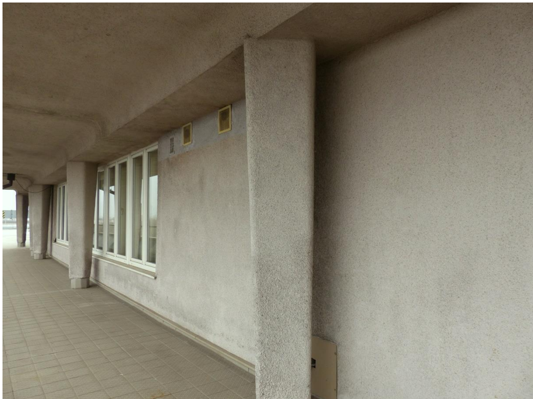
21. Widok w kierunku południowym tarasu siódmego piętra, przed wykonaniem odkrywek nr 2 i nr 3 na ścianie i na słupie, przedstawionymi na pierwszym planie na fotografii.
