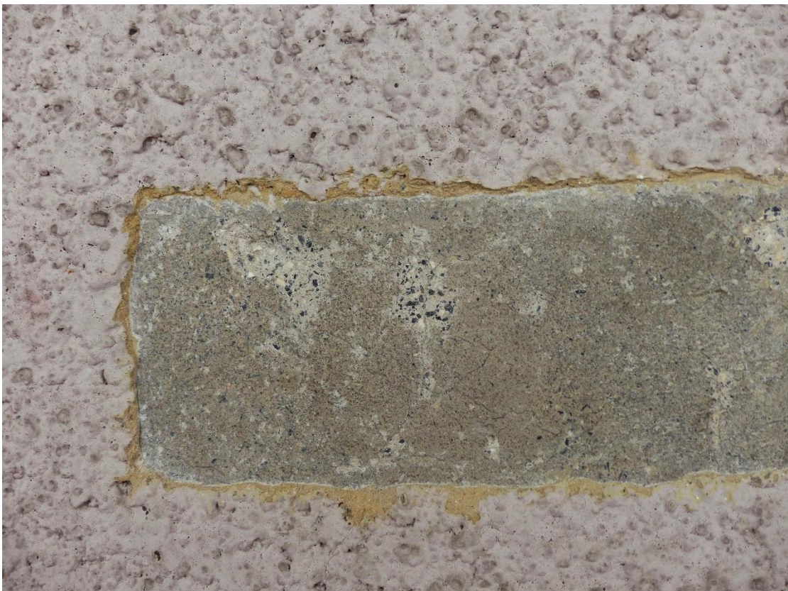
25. Fragment odkrywki nr 2 z lewej strony, z odsłoniętą warstwą wierzchniego oryginalnego tynku.
