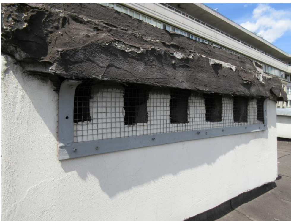
Fot. 16. Zabezpieczone otwory wentylacyjne na dachu biblioteki.
