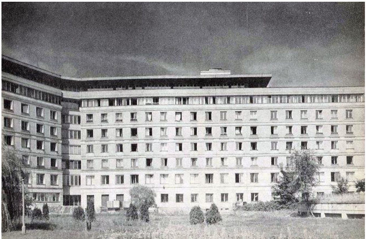
43. Widok na elewację południowo-wschodnią budynku „B”, prawdopodobnie z lat 60-tych.
