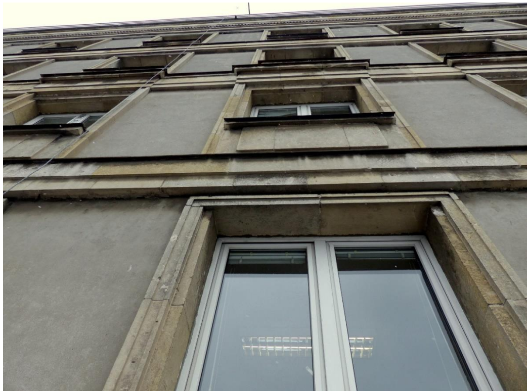
14. Widok od dołu z poziomu drugiego piętra na fragment elewacji zachodniej skrzydła „C”, z detalami architektonicznymi opracowanymi w kamieniu (wapień) i polami otynkowanych ścian płaskich, w tle.
