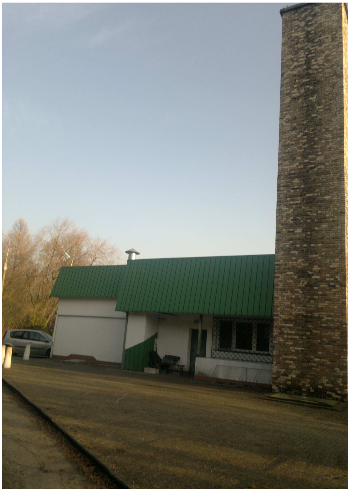
Widok ogólny budynku kuchni (z jadalnią) – kotłownia w podpiwniczeniu z lewej strony budynku
