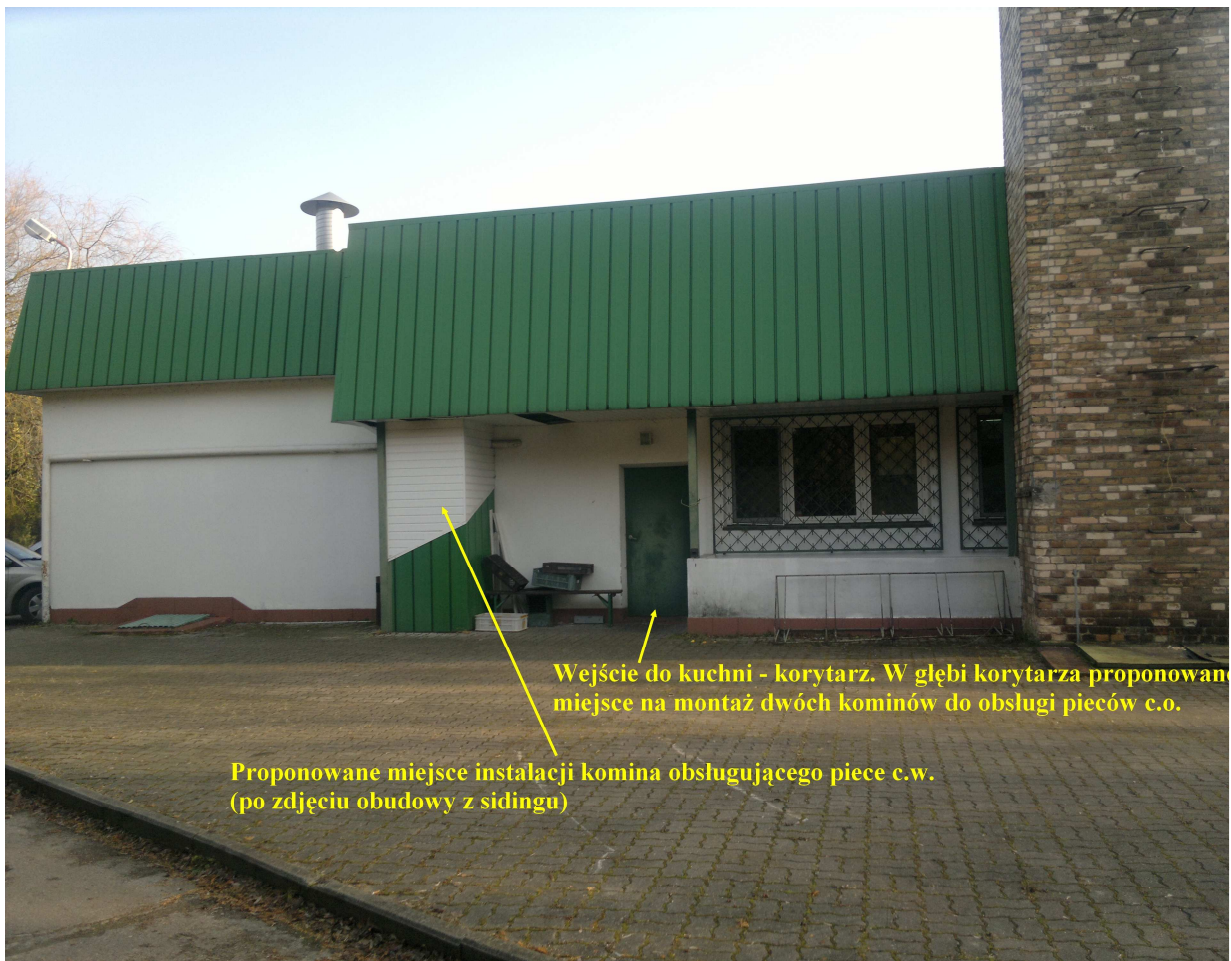
Zachodnia zewnętrzna ściana budynku z zaznaczonymi proponowanymi miejscami montażu nowych kominów.
