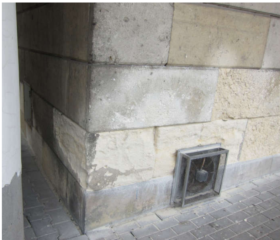
Fragment Skrzydła prostopadłego do Al. Niepodległości .Widok od strony łącznika.
