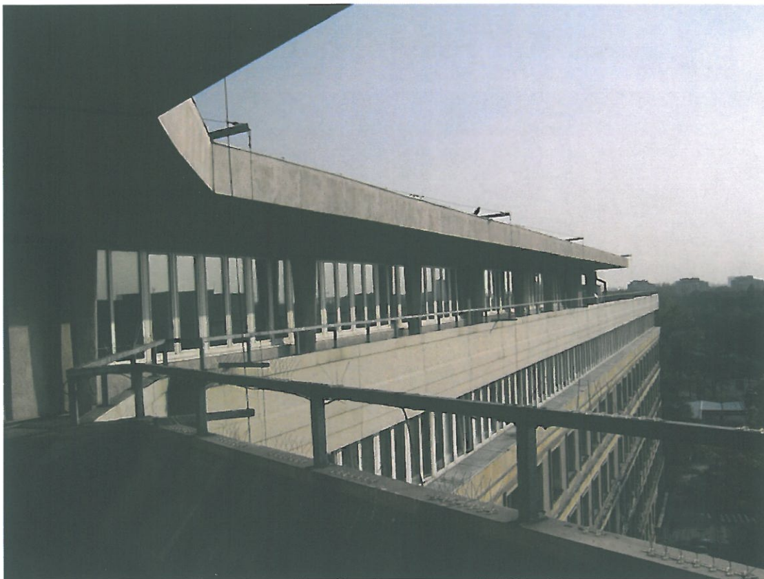
Fot. 4 Taras na VII piętrze
