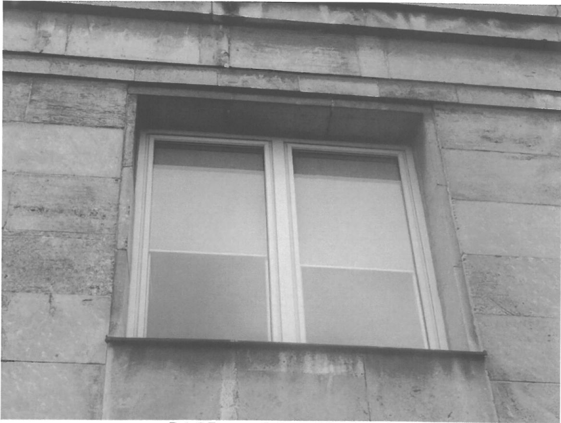
Fot. 6 Fragment elewacji kamiennej
