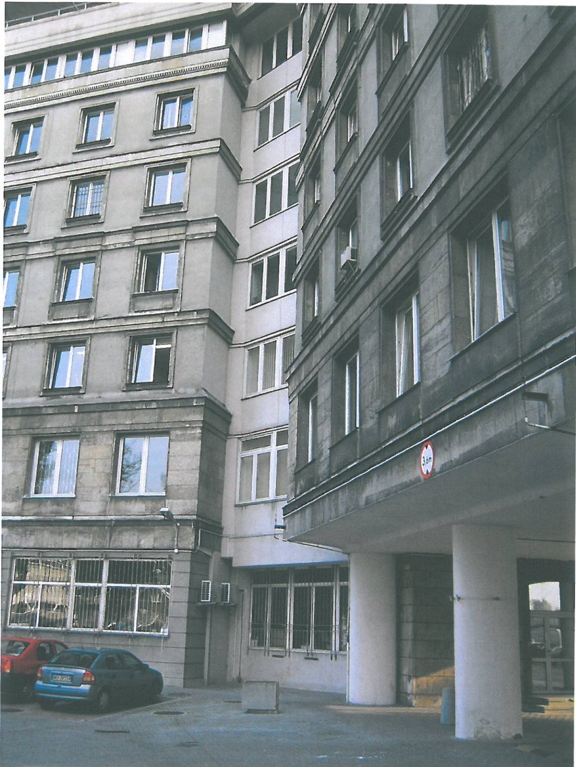
Fot. 3 Fragment elewacji na styku skrzydeł
