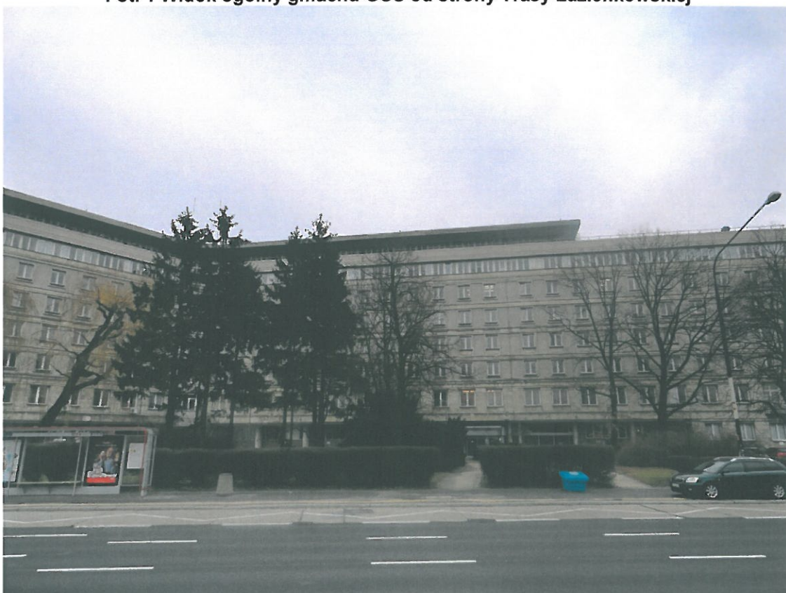
Fot. 2 Widok ogólny gmachu od Al. Niepodległości
