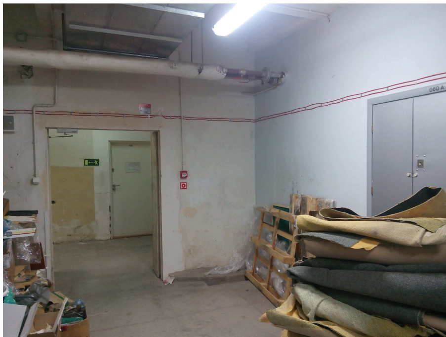
Fotografia nr 1; Piwnica-widok na przejście pomiędzy skrzydłem C i D.
