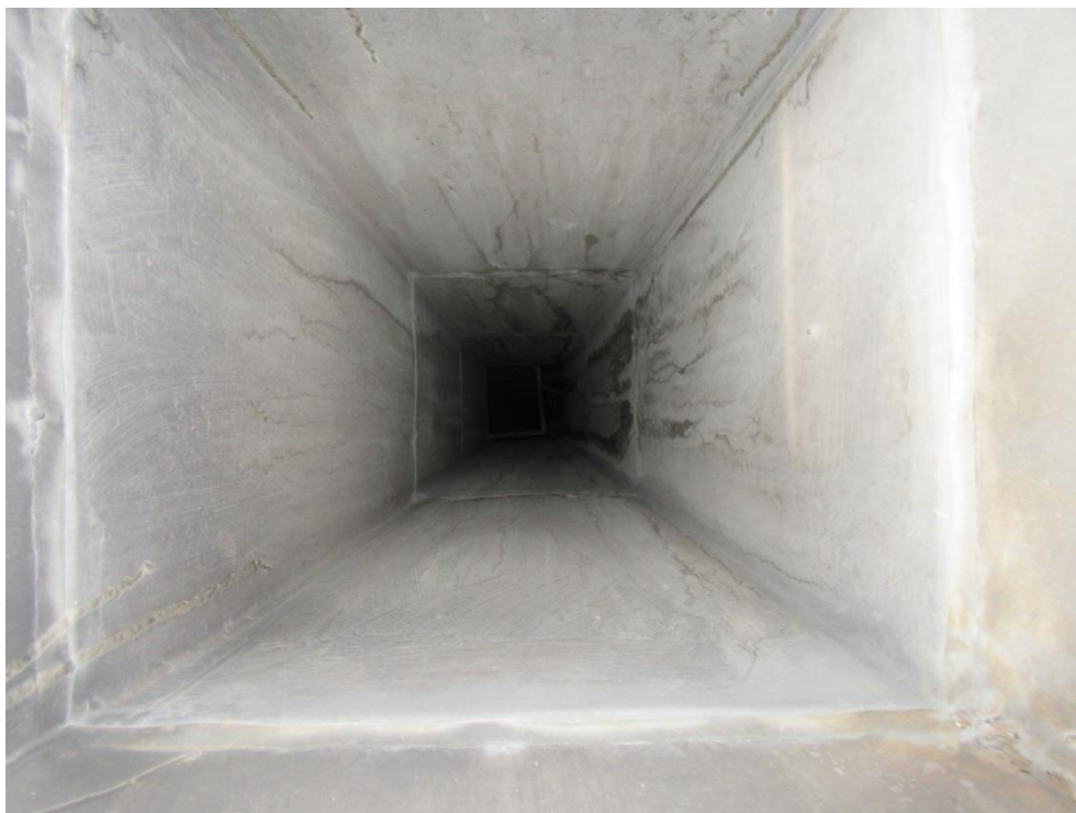
Fot. 7. Światło kanału wentylacyjnego na dachu głównego budynku.
