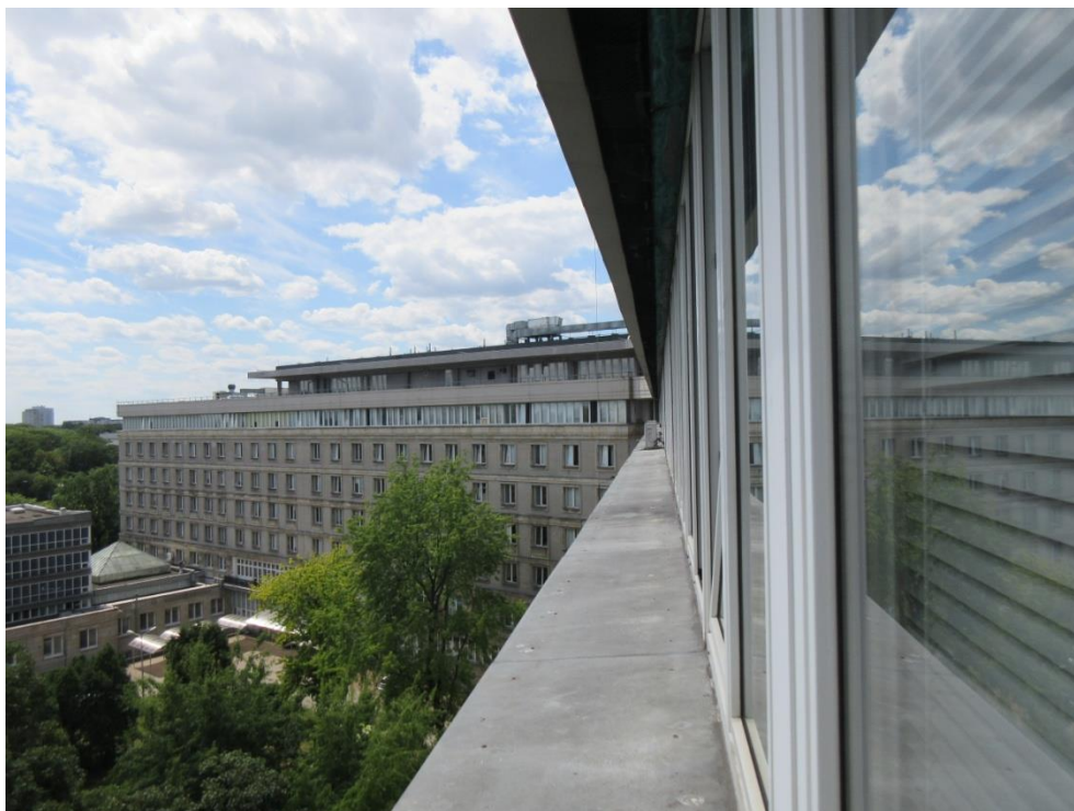
Fot. 1. Elewacja budynku od dziedzińca na strony wschodniej.
