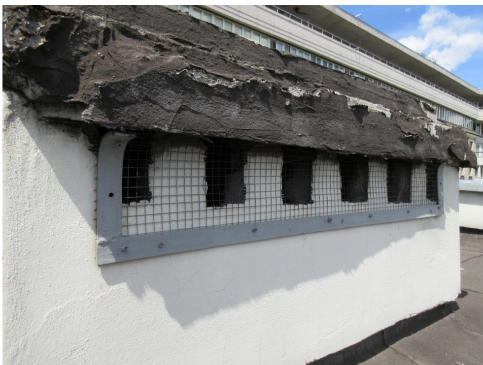
Fot. 16. Zabezpieczone otwory wentylacyjne na dachu biblioteki.
