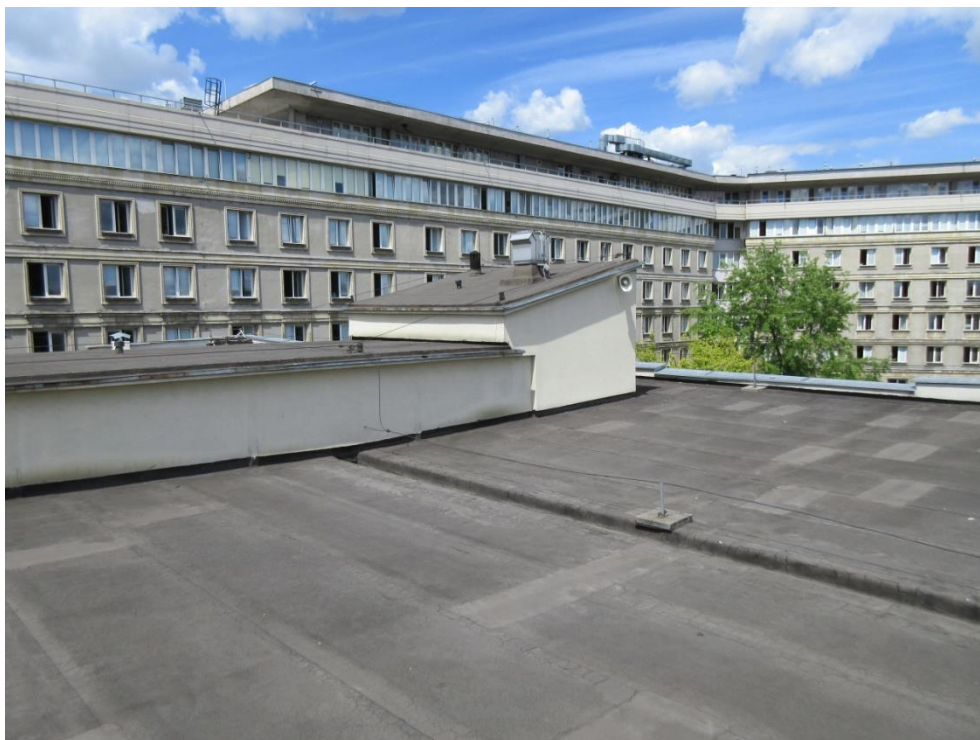
Fot. 3. Dach biblioteki.
