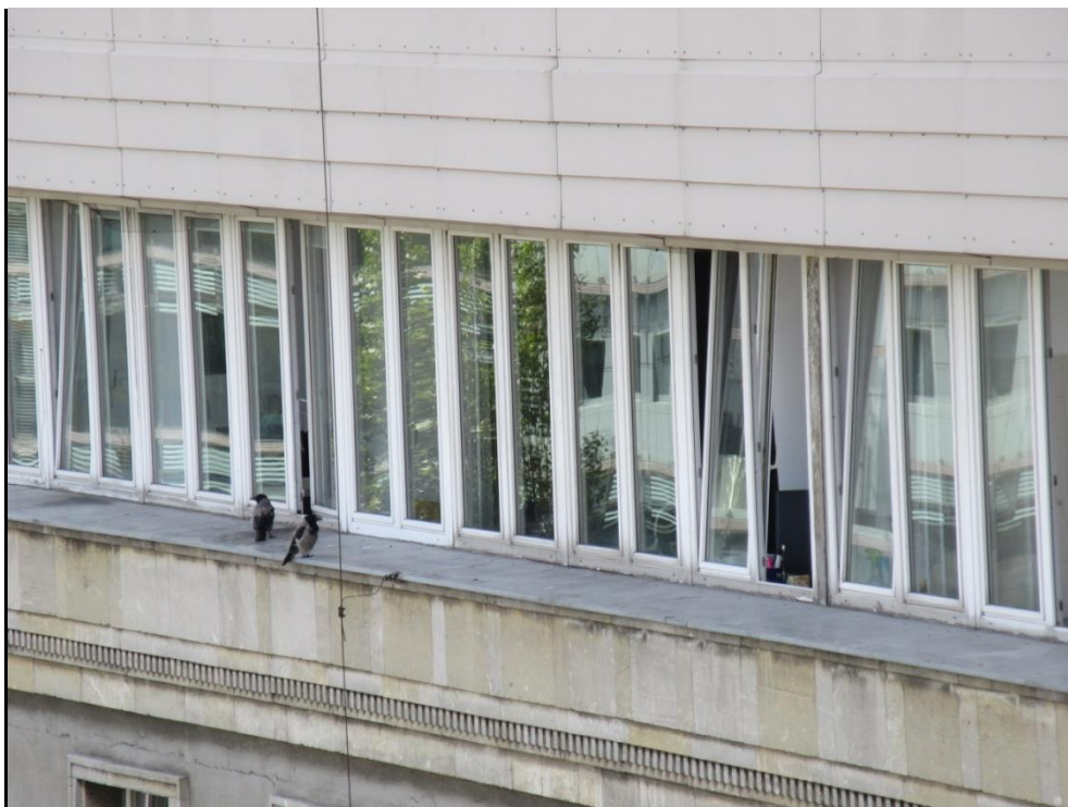
Fot. 19. Wrony siwe.
