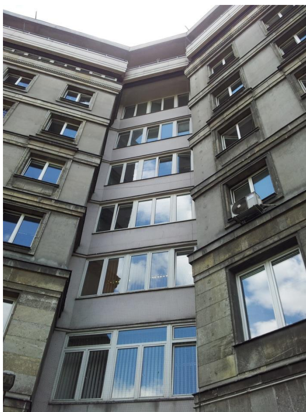
Fot. 28. Boczne ściany wnek w miejscu łączenia skrzydeł budynku – proponowana lokalizacja budek dla wróbla.
