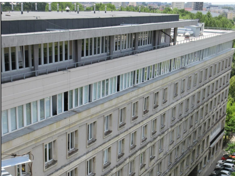
Fot. 2. Elewacja zachodnia od al. Niepodległości.
